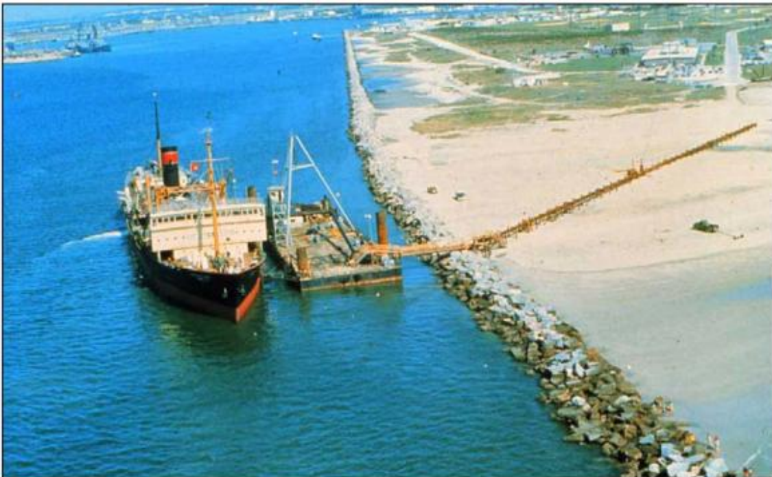
Figura 24- Uma draga do tipo Hopper lançando sedimentos dragados diretamente para um CDF, nos USA.
