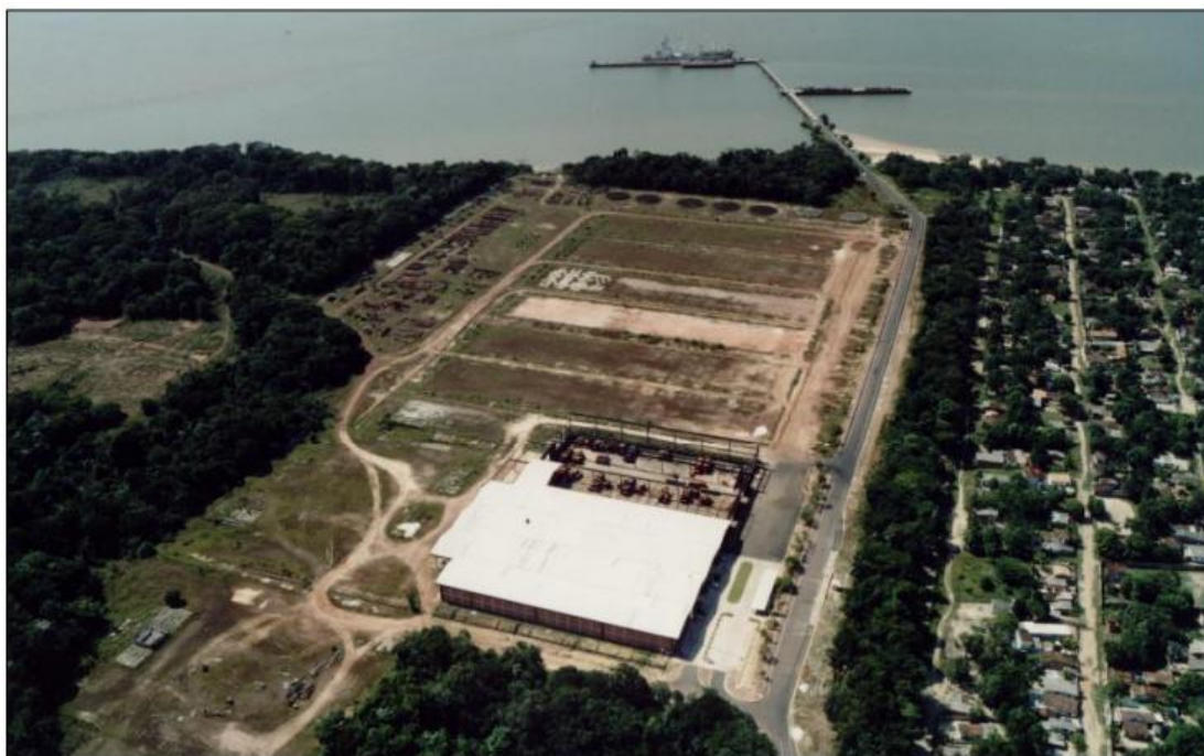
Figura 38- Vista aérea do Terminal Portuário de Outeiro.
