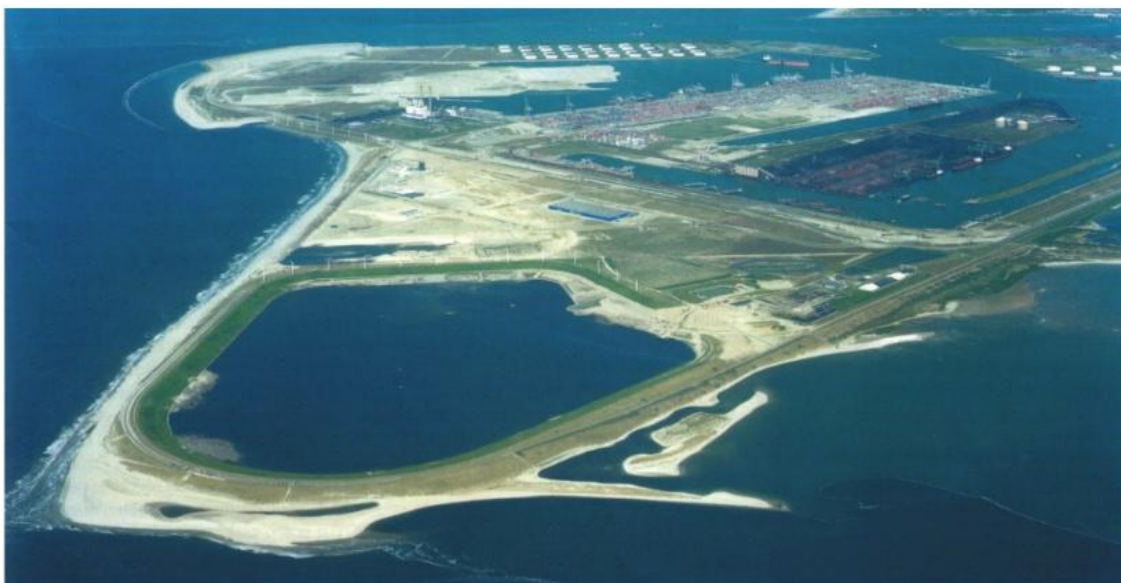
Figura 27- CDF da Slufter na Holanda, um local de depósito confinado para material dragado contaminado.
